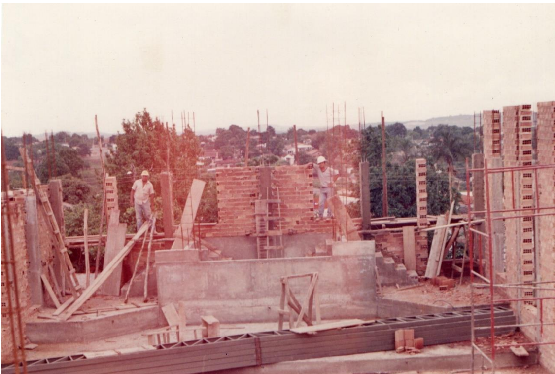
Foto construção do púlpito e tanque batismal da igreja
