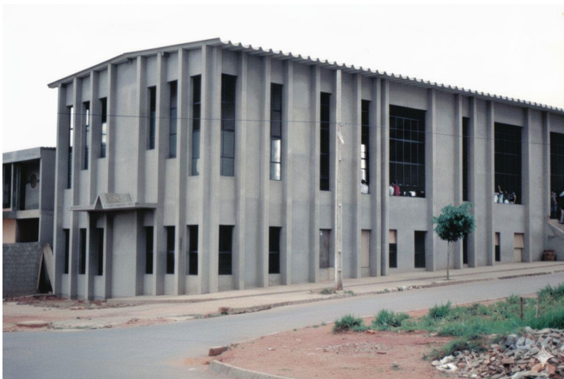
Igreja concluída em fase de pintura e acabamento
