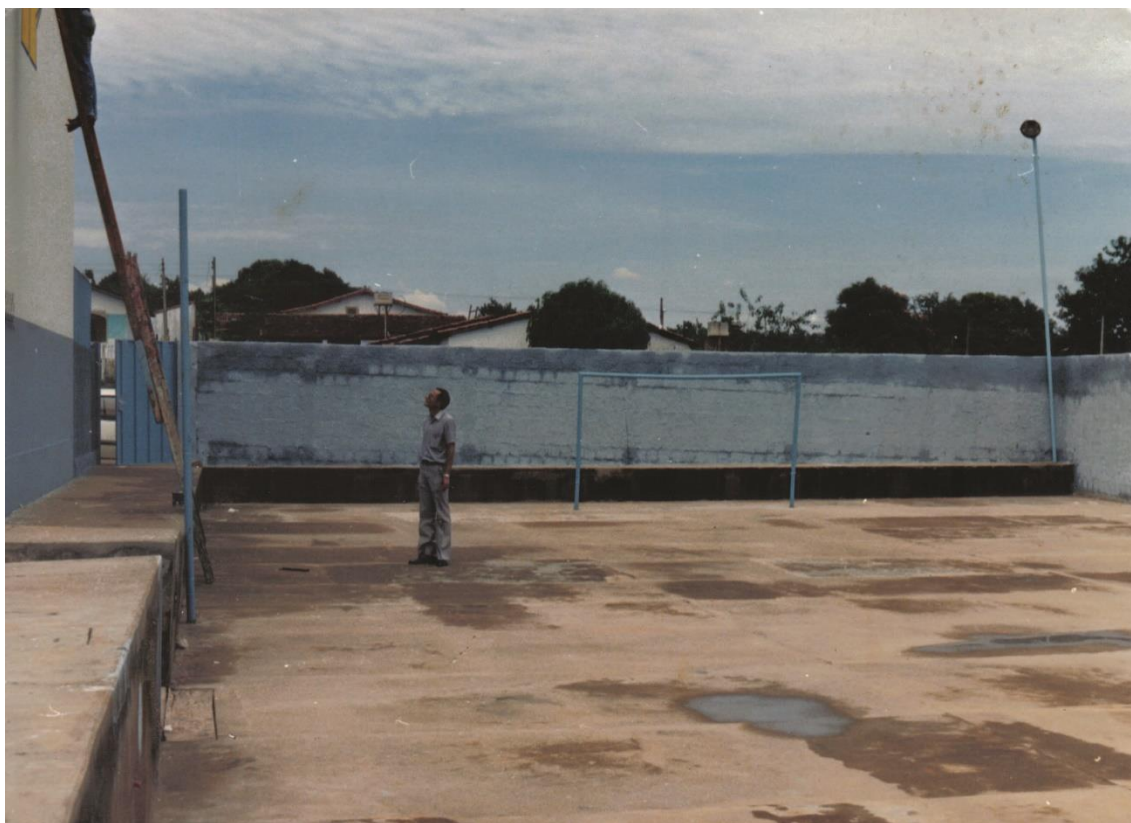
Prof. Anísio Chagas vistoriando execução de serviços na quadra da Escola
